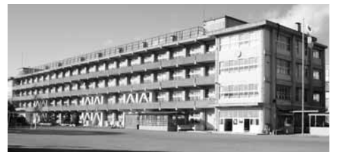
栃木中央小跡地写真
